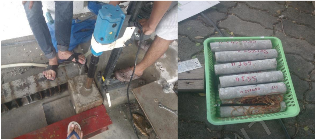
รูปที่ 3.14 การเจาะตัวอย่างคอนกรีต
