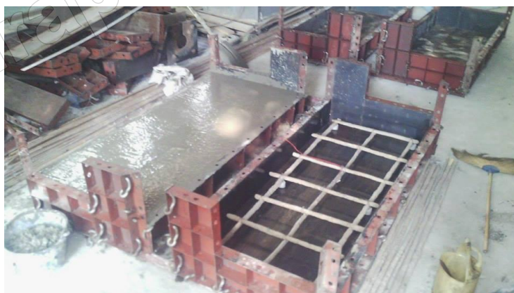
รูปที่ ข-6 โครงไม้ไผ่เคลือบอีพ็อกซี่ที่นำไปเสริมในพื้นที่คอนกรีตและการเทแผ่นพื้นคอนกรีต
