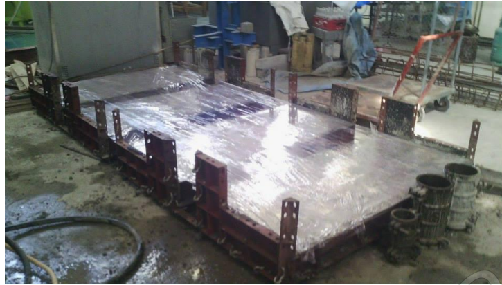
รูปที่ ข-7 การบ่มแผ่นพื้นคอนกรีตเสริมไม้อัดเคลือบอีพ็อกซี่
